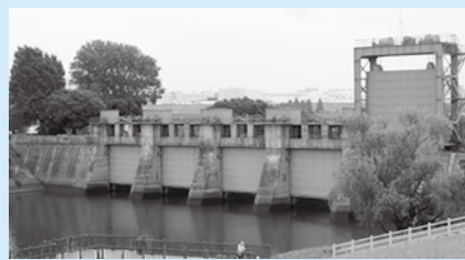
写真2 旧岩淵水門 (筆者撮影)
